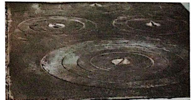
Foto 6: Sustitución de plancha de metal de 3 hornillas
